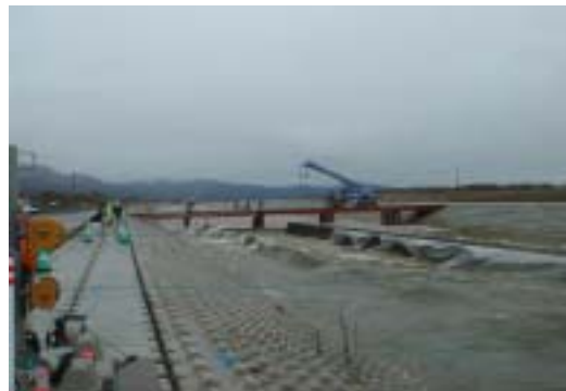
図-4 流量約 50\text{m}^3/\text{s} における水面波列全体の様子
