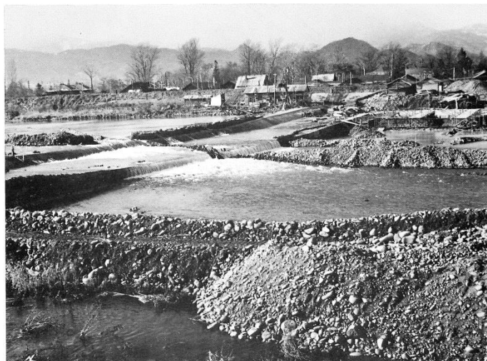
7号床止直下流に6号床止を新設中
