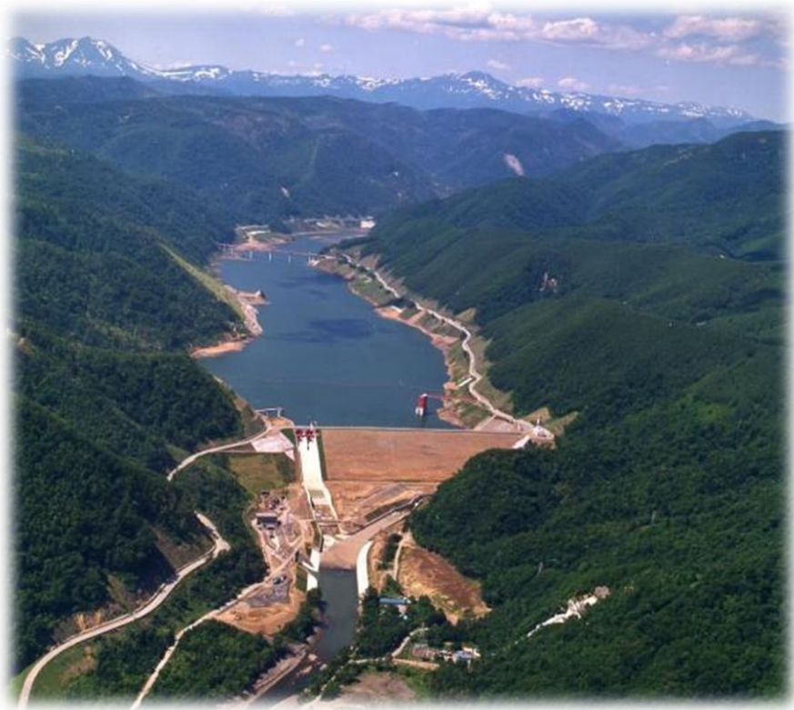
ダムは多様な土木技術の集成体(初任地の十勝ダム)
