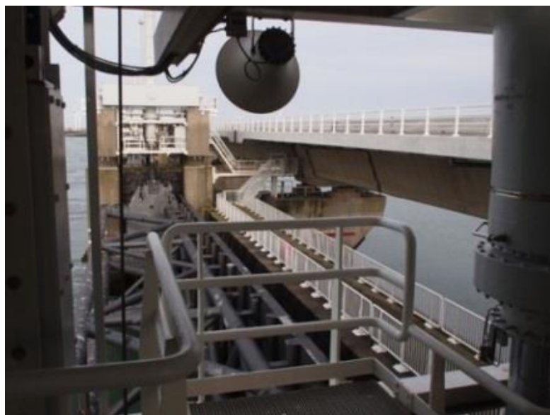
堰柱内の見学用通路
