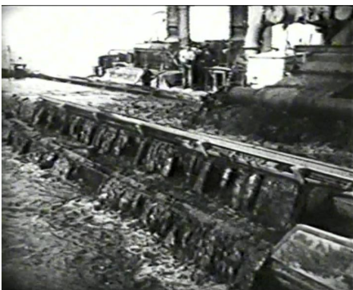
干拓地を高潮から守る堤防の築造
