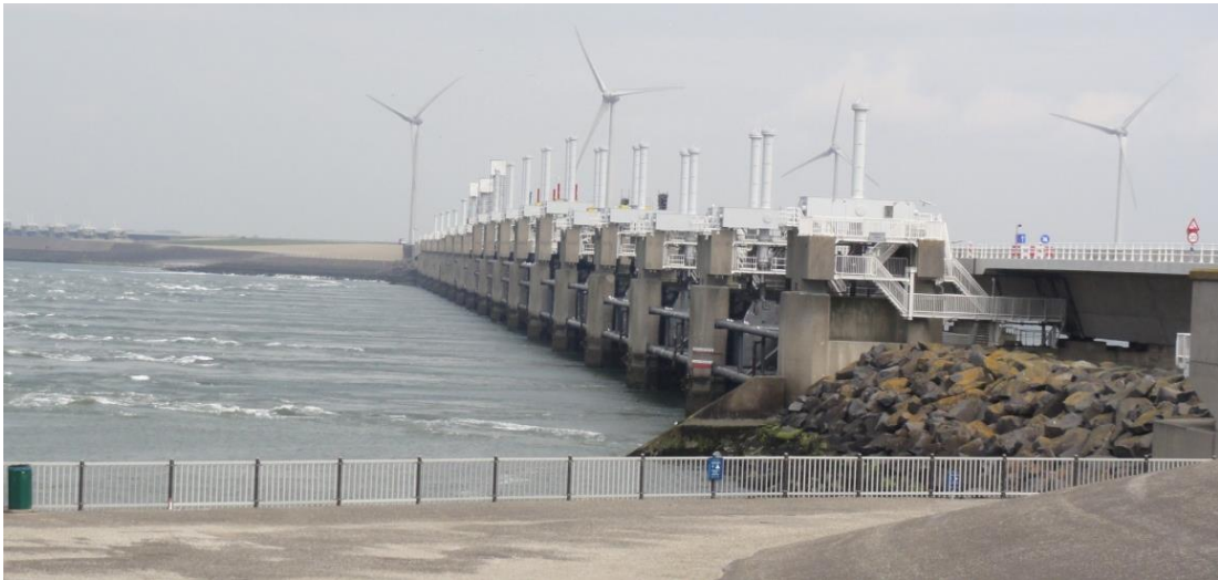
水門は通常開扉されている(左が北海)
