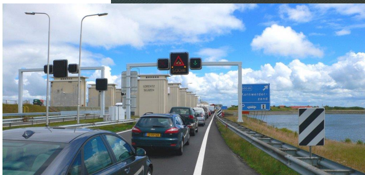
ロレンツ複合閘門（Lorentzsluizen） フリースラント州側の閘門と締切水門
