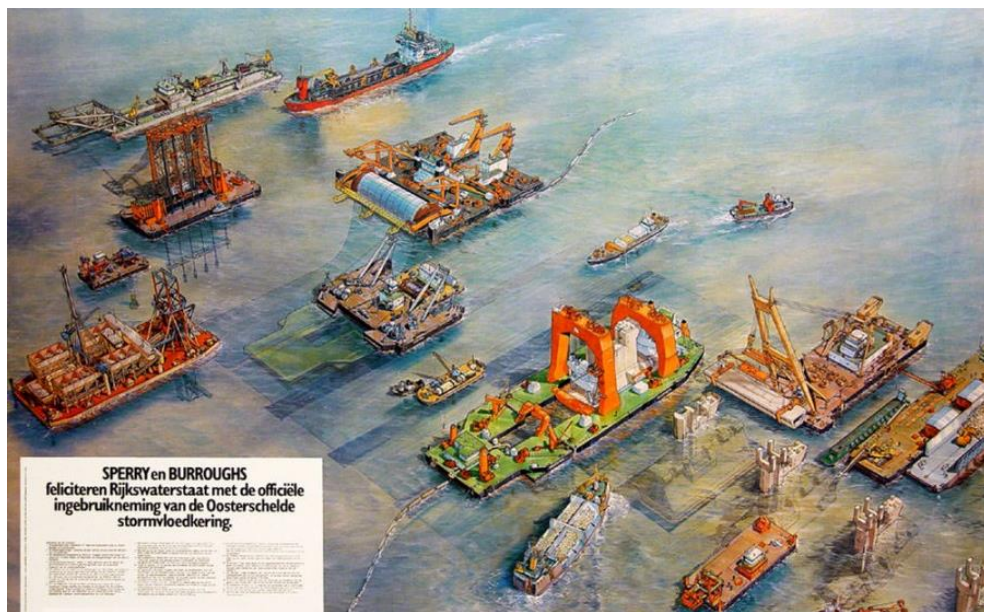
東スケルデ防潮堰の建設機械
