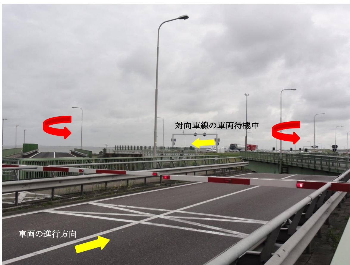
欧州自動車道を通行止めして閘門を開扉（橋梁はそれぞれ矢印の方向に回転中）
