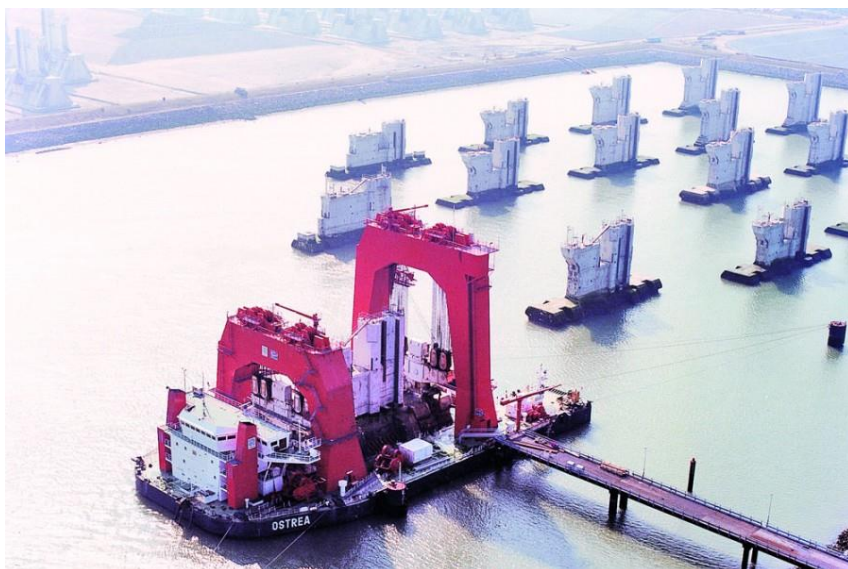
堰柱はドックでプレキャストされた
