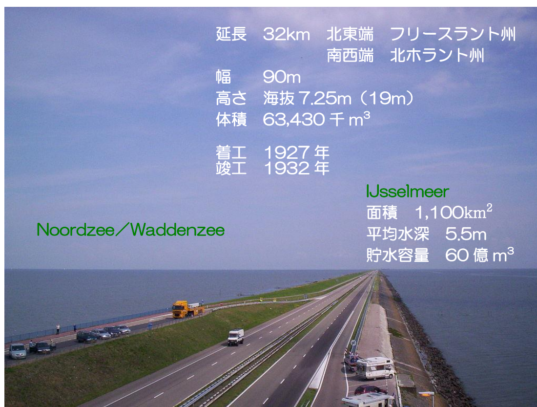
締切大堤防 (Afsluitdijk)
