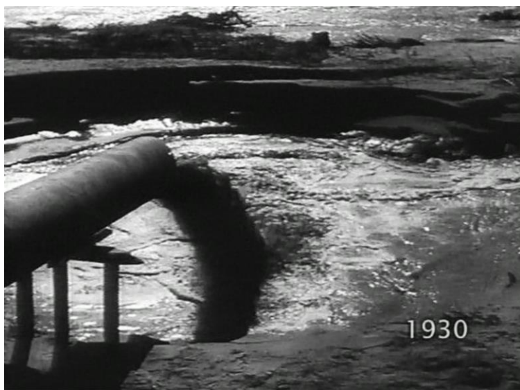
ポンプによる排泥
