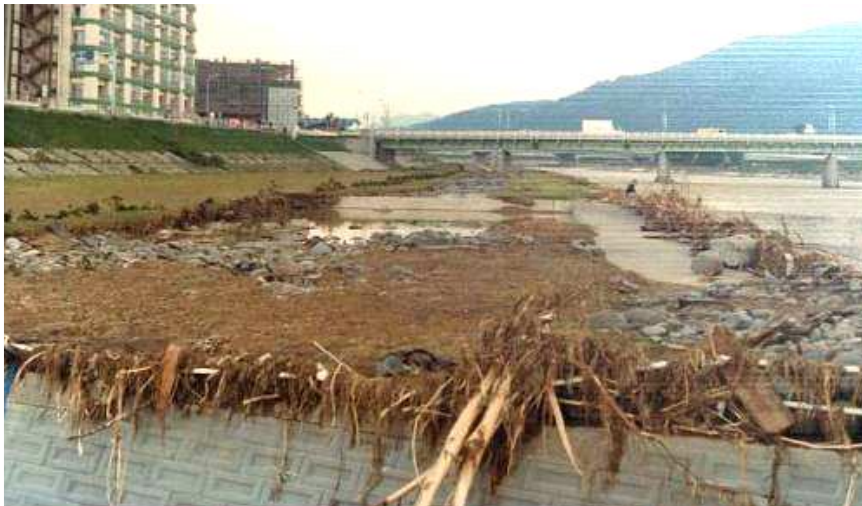
高水敷被災状況(豊平川・6号床止下流右岸)
