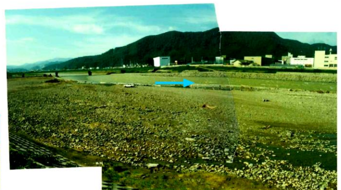
土砂堆積状況(豊平川・8号床止付近)
