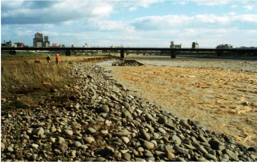
河岸浸食と土砂堆積状況(豊平川・南 22 条大橋上流左岸)
