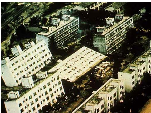
液状化による被害(新潟地震(1964年))
