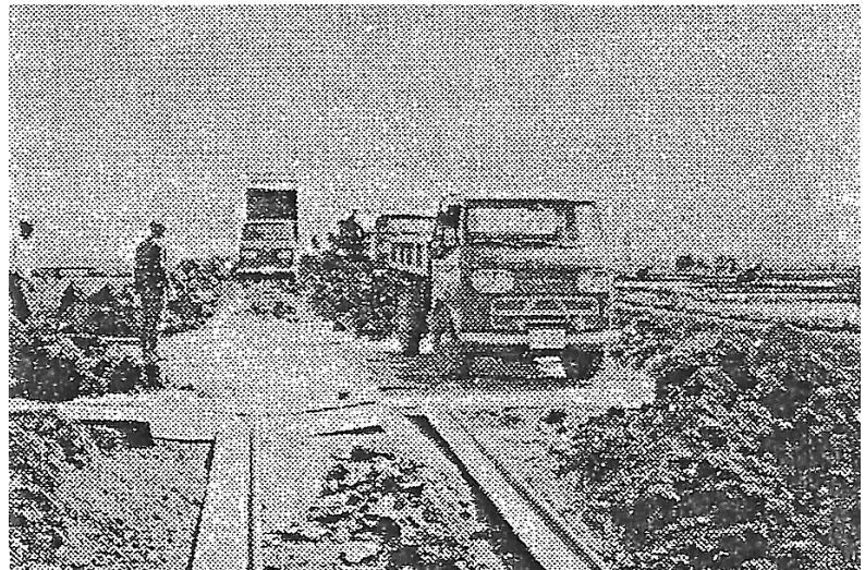
車両待避所と敷設された矢板(野津幌川 KP. 2. 3km 付近)
