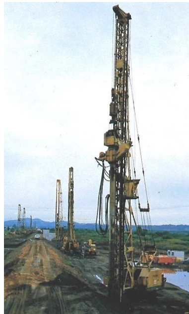
サンドコンパクション工法 による軟弱地盤処理
