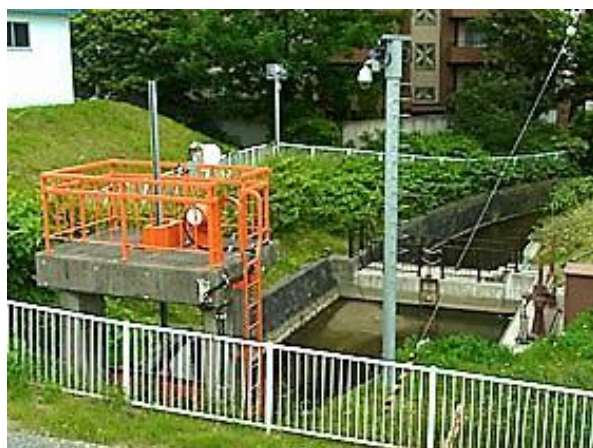
創成川樋門（堤外側と堤内側）
